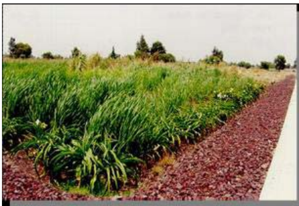
Fig. 18: Humedal artificial para tratamiento de aguas residuales. México.
