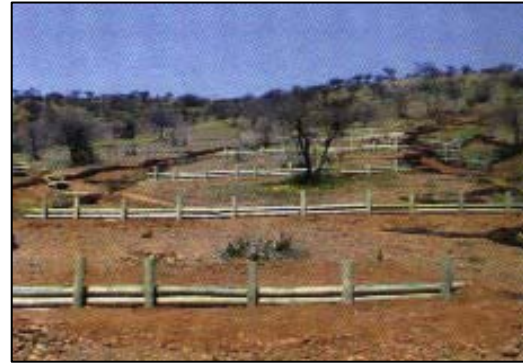
Fig 12 Empalizada: obra de regulación de flujos hídricos y de contención de sedimentos en taludes, cárcavas y laderas inestables.
