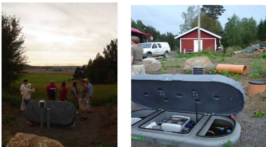
Fig. 17: Sistemas descentralizado de tratamiento de efluentes domésticos Lago Borsjön. Suecia.
