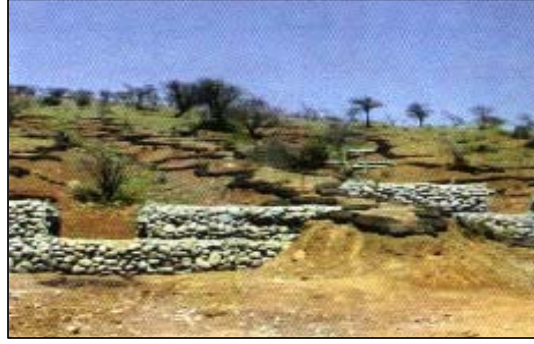
Fig 10 Gaviones: Obra de mampostería para la estabilización y protección de cursos de agua secundarios, generalmente temporales, tales como arroyos, esteros, quebradas y de cárcavas y contención de taludes.
